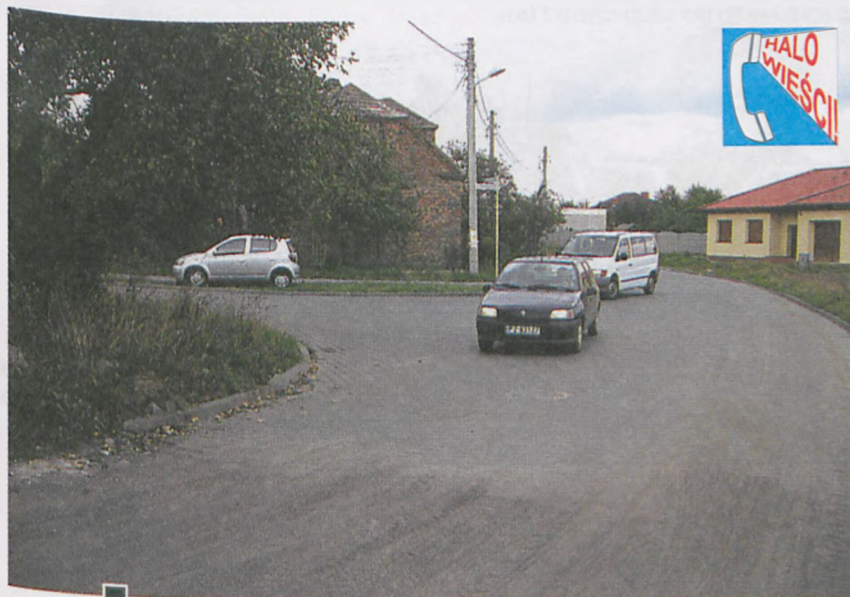
Skrzyżowanie od strony nieutwardzonej ul. Buczka fot. Mateusz Pokrywka
