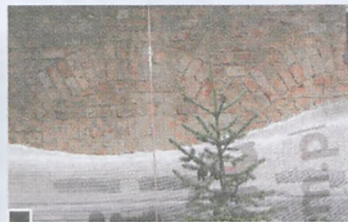
Po zdjęciu tynku ujawniły się łukowe, pierwotne sklepienia najniższej usytuowanych okien fot. Piotr P. Ruszkowski
