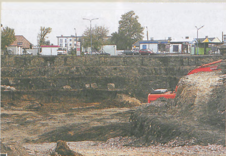
Wykop pod inwestycję o głębokości ok. 8 m. Najniższej widać żółtą warstwę macierzystego podłoża. W głębi zdjęcia – parking i zabudowania Rynecku. Docierają do nas sygnały od zmotoryzowanych klientów targowiska zaniepokojonych bliskością głębokiego wykopu od parkingu, na którym w weekendy tuż przy ogrodzeniu stoi wiele samochodów, co ich zdaniem, grozi obsunięciem gruntu fot. Paweł Jankowiak
