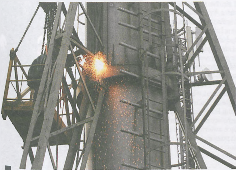
■ Cięcie palnikami gazowymi stalowej konstrukcji starego komina. Pracownicy byli transportowani specjalną klatką zawieszoną na wysięgniku jednego z dźwigów fot. Przemysław Maćkowiak
