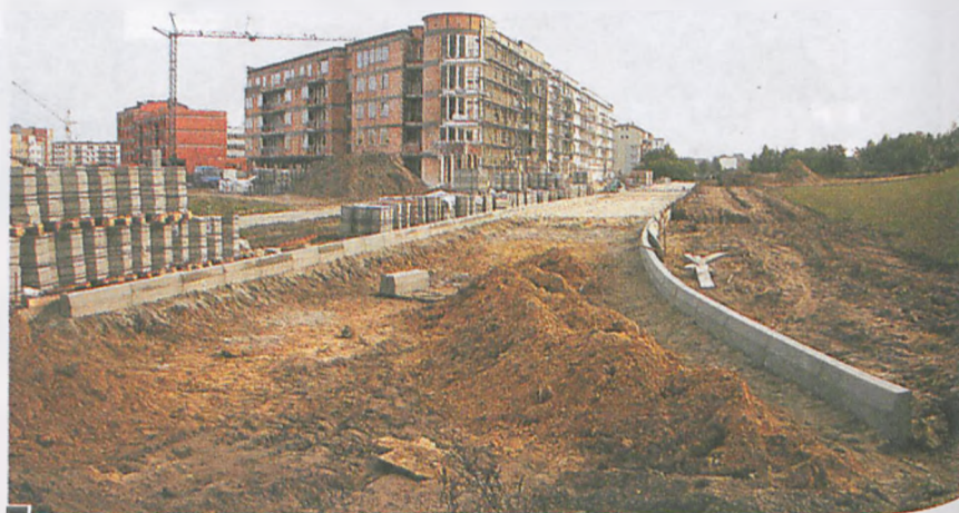
Droga dojazdowa (z trylinki) do nowych bloków w Centrum Lubonia fot. Paweł Jankowiak
