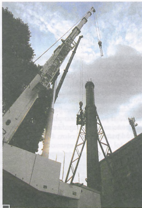
■ Przejeżdżający ulicą Unijną zwracali uwagę na dwa specjalistyczne dźwigi firmy Krupp oraz Liebherr o szczególnie długich wysięgnikach, pracujące w pobliżu osiedlowej kotłowni w Luboniance fot. Przemysław Maćkowiak
