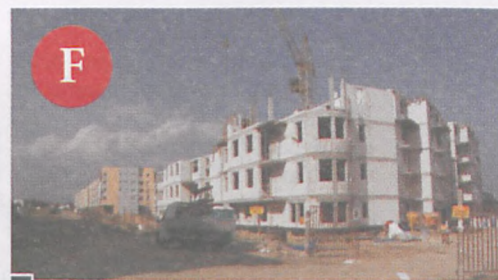
Blok Buddom-Lomexu (siporex) przy al. Jana Pawła II nr 15 w budowie fot. Hanna Siatka
