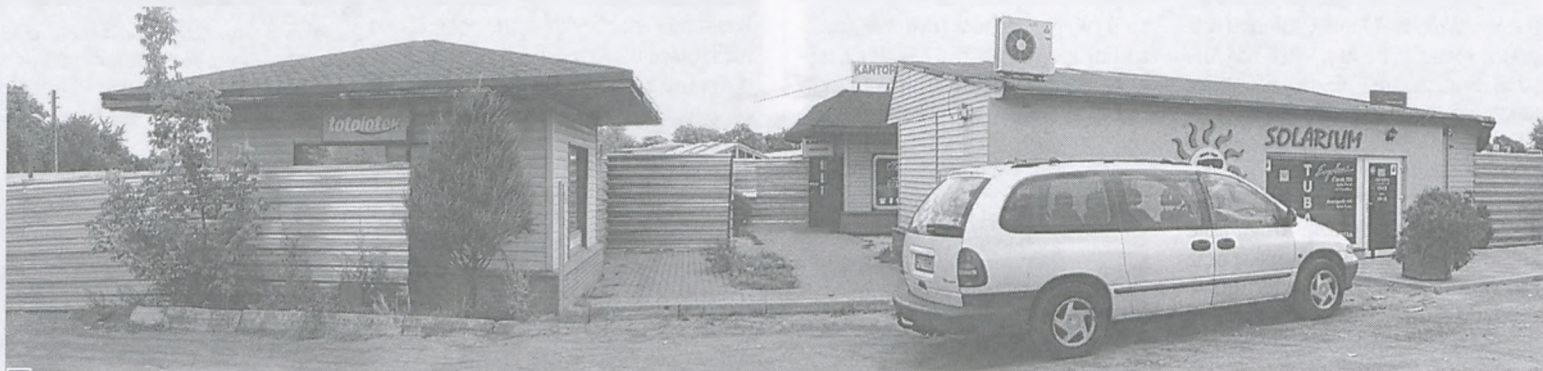
Pozostałe na „placu boju” pawilony dawnej Gesy, od lewej: zasłonięty do połowy płotem TOTOLOTEK, Kantor (w głębi) i Solarium. Za ogrodzeniem trwają regularne prace rozbiórkowe. Odcięto jedyny dojazd – od ul. Paderewskiego, który jest teraz wjazdem na plac budowy fot. Hanna Siatka
