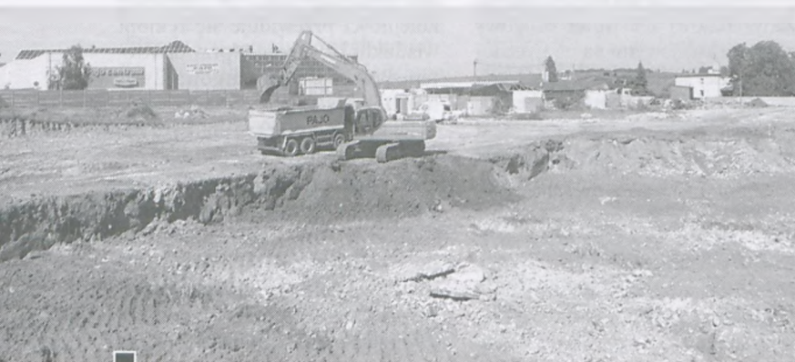
W głębi terenu pomiędzy Ryneczkiem a dawną Gesą trwają prace przy wykopie pod fundamenty przyszłej inwestycji nowego właściciela (widok z parkingu za Ryneczkiem) fot. Hanna Siatka
