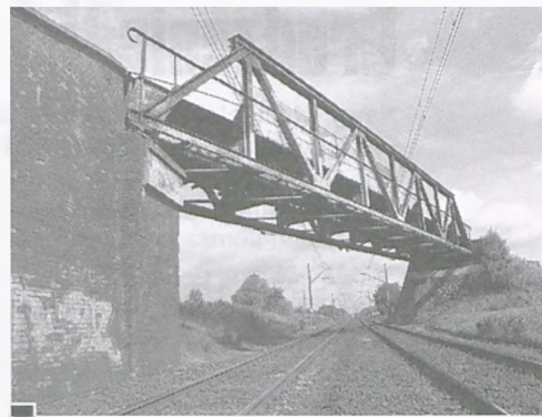
Zabytkowy nitowany wiadukt na trasie do Wolsztyna remontowany będzie z innych środków, może jeszcze w 2009 r. fot. Piotr P. Ruszkowski
