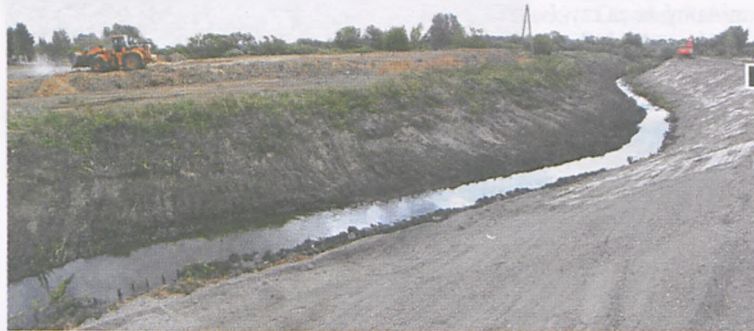
Porządkowany teren ujścia Strumienia Junikowskiego do Warty fot. Piotr P. Ruskowski
