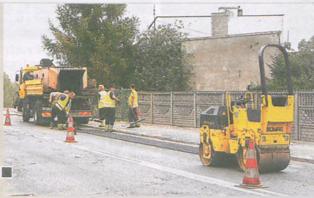
Roboty na ul. Sobieskiego fot. Paweł Jankowiak
