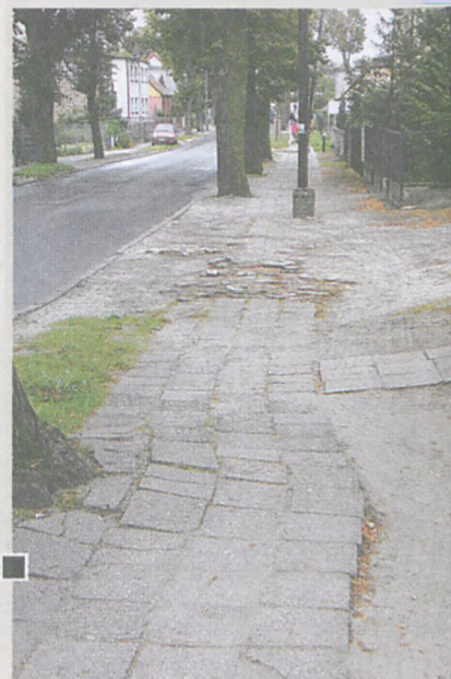
Nierówny, zniszczony chodnik na ul. Poniatowskiego z rzędem słupów energetycznych pośrodku fot. Hanna Slatka
