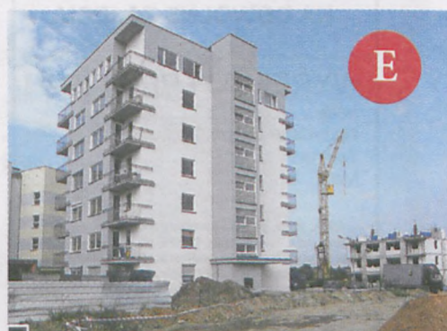
6-kondygnacyjny punktowiec firmy Buddom-Lomex (siporex) przy al. Jana Pawła II nr 20 (widok od ul. Konarskiego) fot. Hanna Siatka
