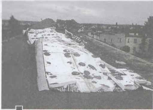
Połączenie odkrytego dachu ze styropianem, papą, opierzeniem fot. Michał Drzewiecki
