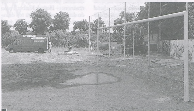
Specjalistyczna firma – Studnie wiercone, poszukiwała wody podziemnej w celu zainstalowania stałego ujęcia do podlewania boiska przy ul. Szkolnej fot. Mateusz Pokrywka
