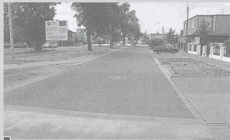
Utwardzony prywatnie dojazd ul. Armii Poznań w kierunku ul. Chopina fot. Piotr P. Ruskowski
