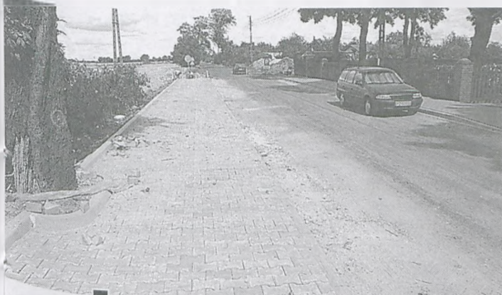
Gmina Komorniki w Wirach buduje utwardzoną drogę do cmentarza, która jest przedłużeniem lubońskiej ul. Poznańskiej fot. Piotr P. Ruskowski
