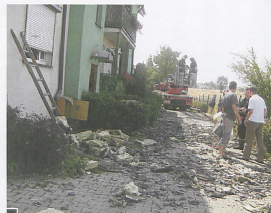
Zrzucone dachówki i ocieplenie fot. Katarzyna Frąckowiak
