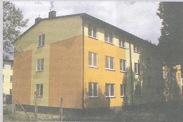
Budynki zostały ocieplone, pokryte tynkiem i pomalowane fot. Jan Błaszczak
