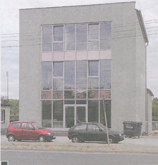
Budynek hurtowni przy ul. Armii Poznań fot. Mateusz Pokrywka
