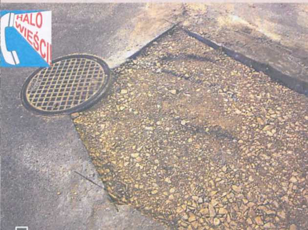
Zdjęcie wykonane nocą, bezpośrednio po przygotowaniu miejsca. Następnego dnia wypełniono je asfaltem. fot. Piotr P. Ruszkowski
