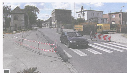
W związku z robotami na Fabrycznej, objazd w ul. Dworcowej fot. Piotr P. Ruszkowski
