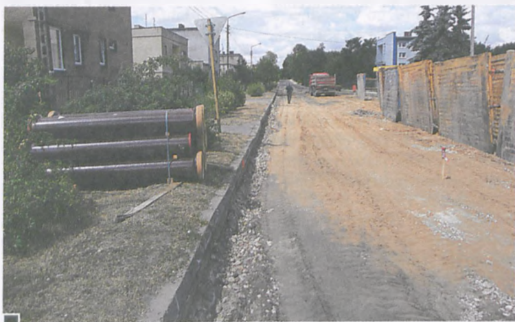
Rozpoczęto prace przy budowie kanalizacji ul. Fabrycznej. Główny kolektor sanitarny będzie miał średnicę 20 cm (po lewej na zdjęciu), a kanalizacja deszczowa – 50 cm fot. Piotr P. Ruszkowski
