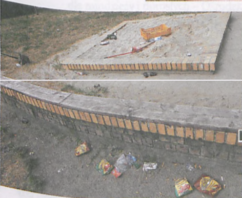
W piaskownicy i wokół niej widać rozbite butelki, wyrwane wraz z betonem kosze na śmieci i resztki po libacji (np. butelki po szampanie, piwie i wódce) fot. Piotr P. Ruskowski
