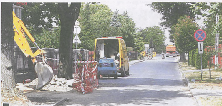
Wykonywanie podłączeń w ul. Rejtana
