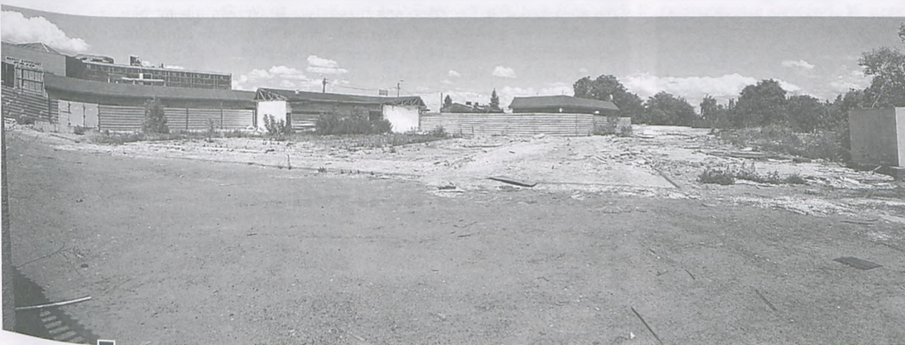
Widok Gesy od strony Ryneczku. Większość pawilonów na terenie Gesy została już zburzona fot. Paweł Jankowiak
