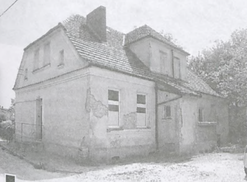
Budynek komunalny przy ul. Okrzei od zaplecza. Kiedyś mieściła się tu siedziba Polskiej Zjednoczonej Partii Robotniczej, później prywatne gabinety lekarskie, dalej Miejski Ośrodek Pomocy Społecznej, a do ub. roku Przychodnia Lekarza Rodzinnego. Obecnie opuszczony, czeka na sprzedaż lub zagospodarowanie przez właściciela – miasto fot. Hanna Siatka
