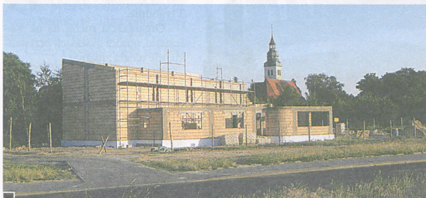
Hurtownia w budowie. W tle kościół pw. św. Barbary fot. Hanna Siatka
