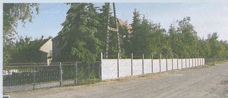
Parkan w trakcie budowy fot. Hanna Siatka
