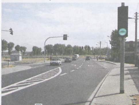
Ulica Poniatowskiego z nowym pasem ruchu i sygnalizacją z ul. Przy Autostradzie fot. Paweł Jankowiak
