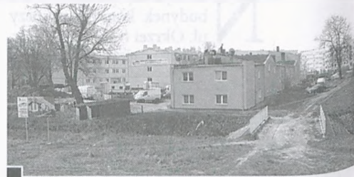
Widok budynków komunalnych od strony ul. Unijnej. Z lewej nowe domy, które będą zasiedlane jesienią. W jednym powstaną mieszkania socjalne (m.in. więcej lokatorów w jednym lokalu, umowa tylko na rok), w drugim – mieszkania komunalne (m.in. mniejsze zagęszczenie, umowa bezterminowa, kaucja). Z prawej – odremontowany niedawno budynek, w którym kiedyś mieszkali pracownicy nieistniejącej już cegielni fot. Piotr P. Ruszkowski
