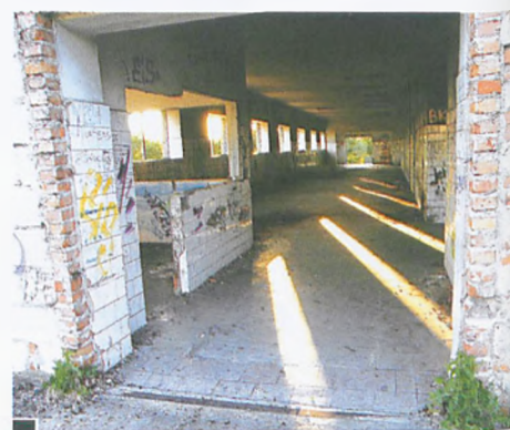
Wnętrze budynku. Tu, zgodnie z zapisami miejscowego planu zagospodarowania, mają powstać mieszkania fot. Hanna Siatka
