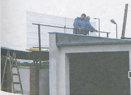
Montaż zabezpieczenia przed niebezpiecznymi wybrykami parkouristów fot. Hanna Siatka
