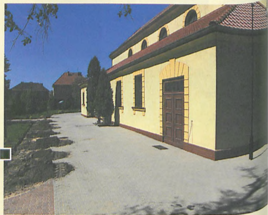
W parafii św. Jana Bosko na ukończeniu jest wykładanie kostką pozbrukową terenu wokół kościoła fot. Piotr P. Ruszkowski
