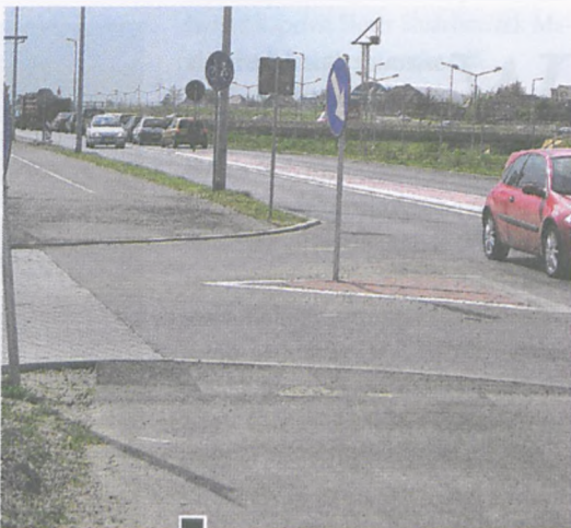
Wyjazd z Biedronki wraz z wysepką i znakiem stojącym dokładnie na środku ścieżki rowerowej; również bez oznakowania – przejścia ścieżki przez ulicę fot. Paweł Perz
