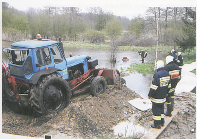
Dla oddzielenia wody ze Strumienia Junikowskiego i szacht użyto ciężkiego sprzętu i specjalnych rękawów do budowy tamy fot. Paweł Jankowiak
