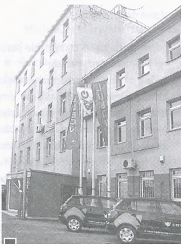
Flagi lubońskich Zakładów Chemicznych przed budynkiem zakupionych przed rokiem nieruchomości upadłej spółki Instal SA przy ul. Józefa Hallera w Poznaniu fot. Hanna Siatka
