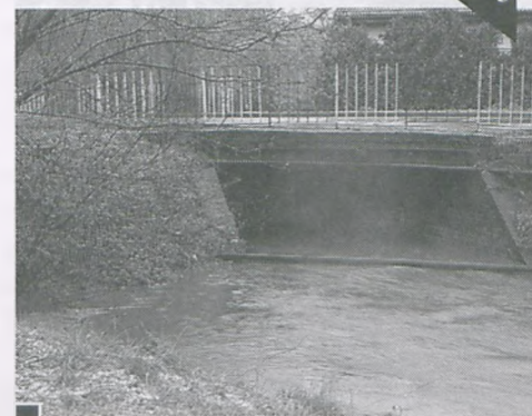
Ulewa spowodowała wypełnienie się wszystkich zbiorników retencyjnych związanych z autostradą fot. Jan Błaszczak
