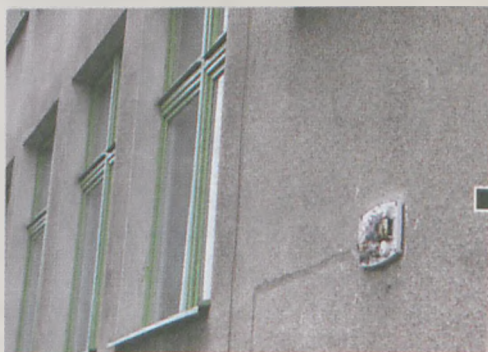
Tak wygląda urządzenie alarmowe zainstalowane na budynku Szkoły Podstawowej nr 3 i Gimnazjum nr 1 fot. Piotr P. Ruskowski
