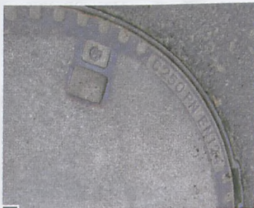
Na okolicznych włazach widnieje sygnatura wytrzymałościowa – 25 ton fot. Piotr P. Ruskowski
