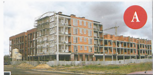
Segment Budo-Formy z adresem ul. Wschodnia 21 w budowie fot. Hanna Siatka
