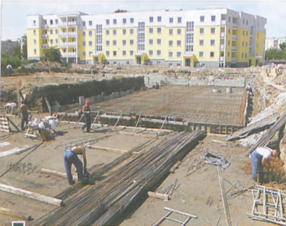
Zbrojenie fundamentów pod nowy blok. W głębi oddawany do użytku budynek przy ul. Sikorskiego fot. Piotr P. Ruszkowski
