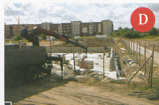
Plac budowy bloku firmy Romos Dom od strony ul. Pułaskiego fot. Hanna Siatka
