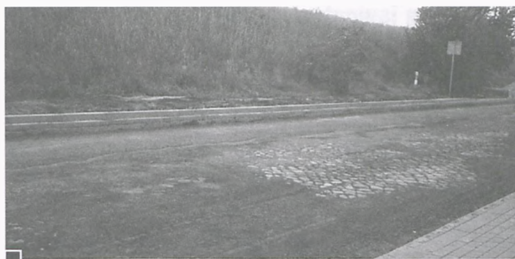
Przy okazji zdzierania starej nawierzchni asfaltowej uwidoczniła się pierwotna droga, w Lasku – brukowa, w Luboniu z cegły układanej w jodełkę fot. Katarzyna Frąckowiak
