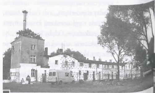
Ocieplanie budynku komunalnego przy ul. Źródlanej. Styropian mocowany jest do łuszczącego się starego tynku fot. Paweł Jankowiak
