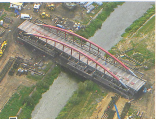
Zakonserwowane i odnowione stare przęsło mostu św. Rocha, usytuowane jeszcze na Zagórzcu. U dołu fragmenty torowiska, po którym jest ono transportowane na miejsce docelowego posadowienia fot. Przemysław Maćkowiak
