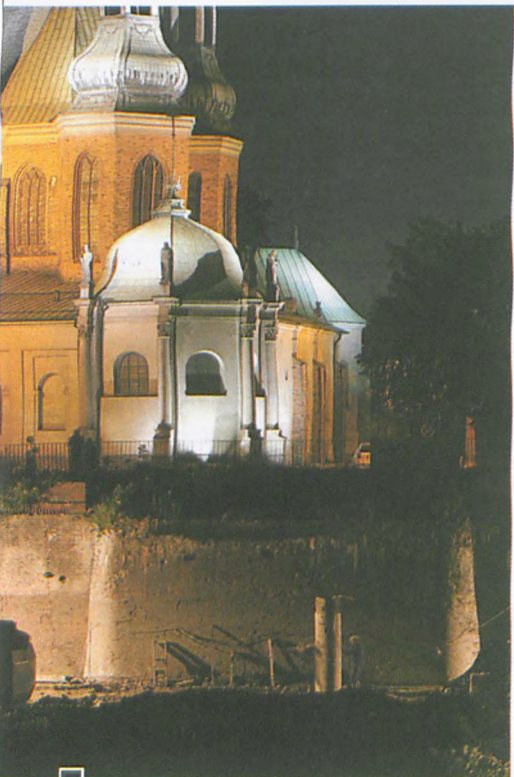
Ceglany przyczółek zachodni dawnego mostu cybińskiego, przed którym powstaje nowa konstrukcja żelbetowa. Prace, jak widać, prowadzone są także w nocy, w głębi oświetlona poznańska katedra fot. Przemysław Maćkowiak
