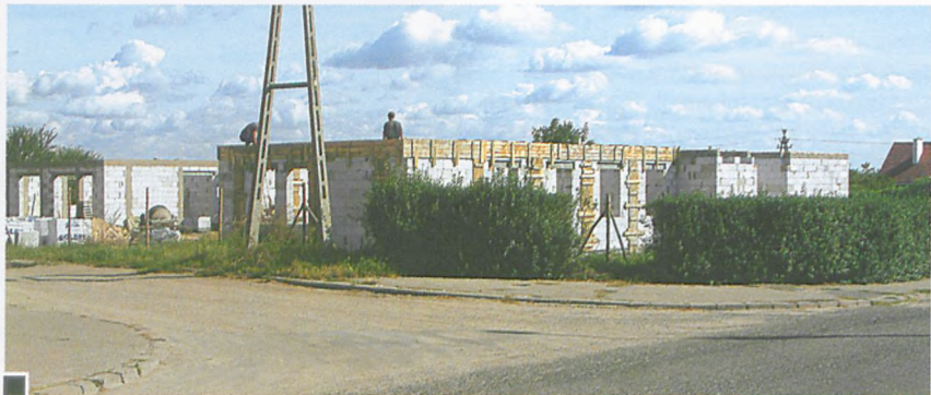
Plac budowy nowych gabinetów specjalistycznych przy ul. Żeromskiego fot. Hanna Siatka
