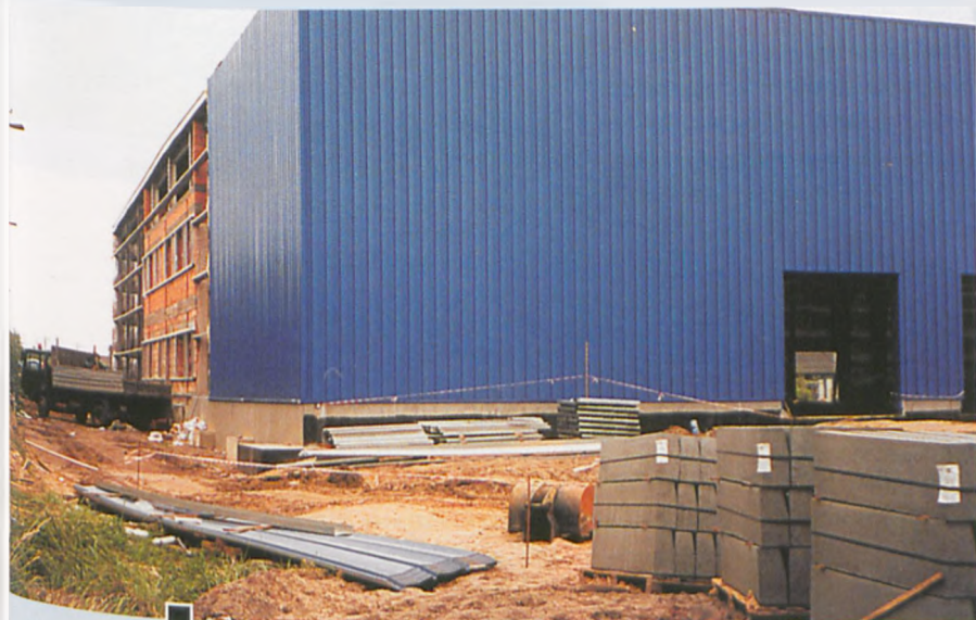
Budowana hala Parku Przemysłowego fot. Katarzyna Frąckowiak
