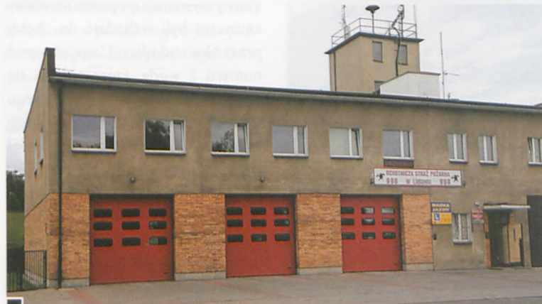
Budynek Ochotniczej Straży Pożarnej wyposażono w nowe, segmentowe, podnoszone bramy fot. Paweł Jankowiak
