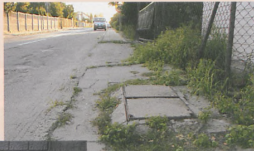
sprawiło, że jego powierzchnia stała się bardzo nierówna. Do tego dochodzą wystające studzienki, w które te chodniki dosłownie obfitują. (B)
