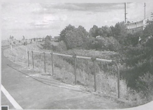
Barierę zabezpieczającą fot. Jan Błaszczak
