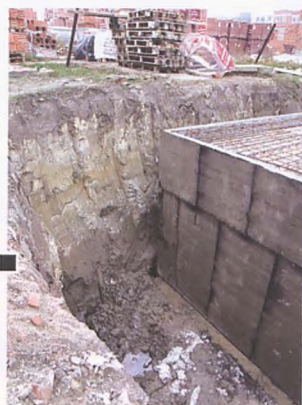
Przekrój ziemi (gliny), w której znajdował się glaz fot. Piotr P. Ruskowski
