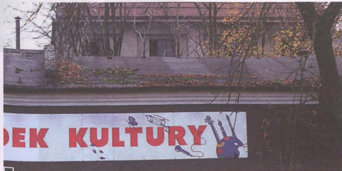
Dach Ośrodka Kultury „Pod Kominem”, dawnego kina, zarośnięty wieloletnim mchem, a rynny zielskiem fot. Piotr P. Ruskowski
