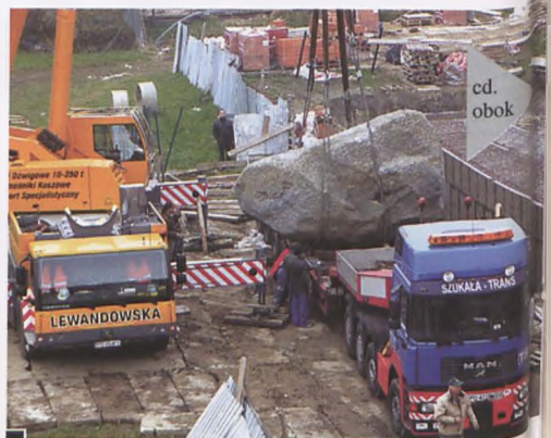
Moment załadunku dokonywany specjalnie sprowadzonym sprzętem firmy „Lewandowski” o udźwigu do 250 ton. Przewóz zapewniła firma „Szukała-Trans” z Poznania fot. Piotr P. Ruskowski
