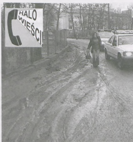
Pojazdy ciężarowe obsługujące budowę bloków Lubonianki przy ul. Źródlanej rozjeżdżyły gruntową część ulicy. Zniszczona została elewacja świeżo odremontowanego budynku komunalnego przy ul. Źródlanej 3 (patrz str. 10). Przejście dla jego mieszkańców jak i petentów znajdującego się tu Miejskiego Ośrodka Pomocy Społecznej wiąże się z przeprowadzeniem przez rzekę błota. Przypomnieć należy przy tym, że z usług socjalnych korzysta wielu niepełnosprawnych fot. Piotr P. Ruskowski
