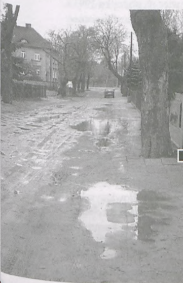
Chcąc poprawić stan nieprzejezdnej ul. Narutowicza, mieszkańcy nawożą systematycznie różny materiał lub proszą o to służby miejskie. Doszło do tego, że poziom jezdni stał się wyższy niż chodnika i woda wlewa się na posesje. W corocznych akcjach równania ulic ciężki sprzęt powinien nie tylko gładzić drogi, ale też zbierać nadmiar niepotrzebnego gruntu fot. Piotr P. Ruskowski
