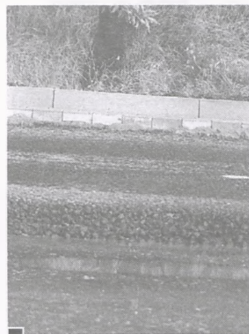
W niektórych miejscach poziom drogi podniesiono o 30 cm fot. Katarzyna Frąckowiak
