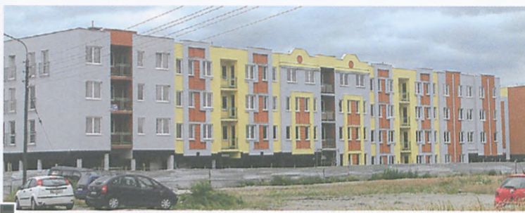
Blok Kos-Domu w fazie wykańczania od strony alei Jana Pawła II – pierzeja zachodnia widoczna od ul. Pułaskiego. Częściowo zachowano arkadowe przyziemie z wykorzystaniem na handel i usługi fot. Hanna Siatka
