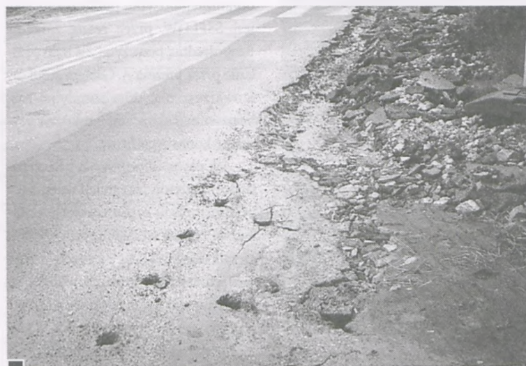
W niektórych miejscach pas dotychczasowej jezdni zwężony jest do 7 metrów fot. Katarzyna Frąckowiak
