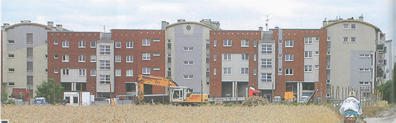
Pierwszy blok w Centrum przy ul. Wschodniej 22 wybudowany przez Budo-Formę w 2003 r. Pierzeja północna od ul. Wschodniej charakteryzuje się 4-kondygnacyjnymi segmentami wykończonymi elewacją z dominacją klinkieru, przedzielonymi 5-kondygnacyjnymi budynkami narożnymi i łącznikami o łukowatych dachach. Charakterystyczna arkada handlowa na przyziemiu, częściowo już zagospodarowana placówkami handlowymi i usługowymi fot. Hanna Siatka
