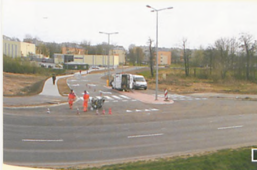
Ostatnie zabiegi – malowanie znaków na jezdni fot. Paweł Jankowiak
