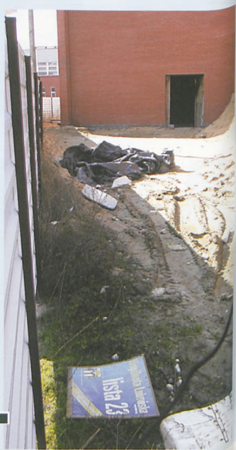
Wyblakły plakat umocowany na płycie piślniowej, na placu budowy hali fot. Piotr P. Ruszkowski
