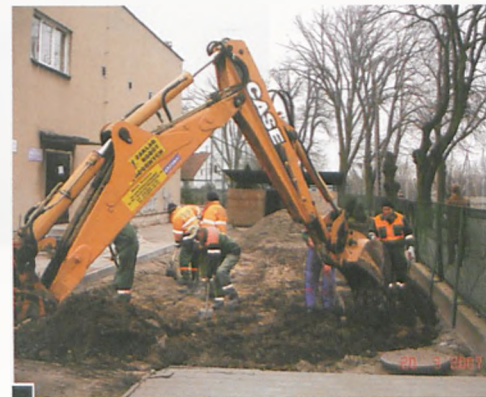
Wymiana gruntu przed układaniem pozbruku fot. Zbigniew Jankowski
