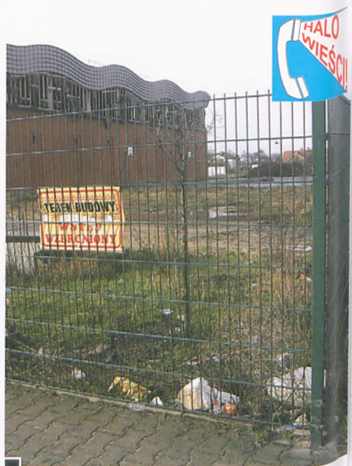
Zaśmiecony i opustoszały teren budowy hali widowiskowej przy ul. Kołtątaja
