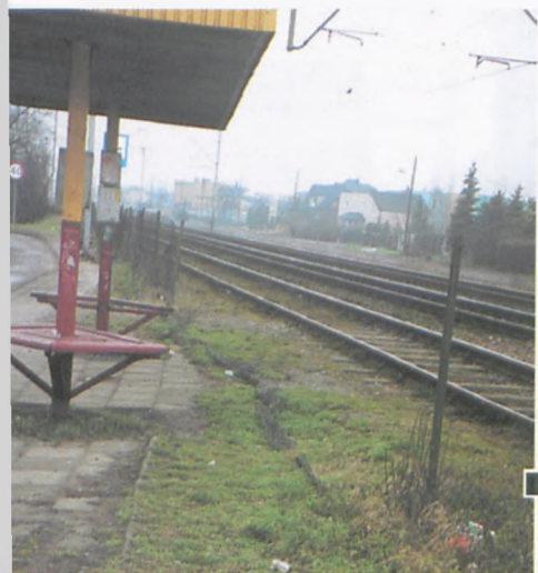
Wdeptany w ziemię płot gradzący przystanek od torów kolejowych fot. Katarzyna Frąckowiak
