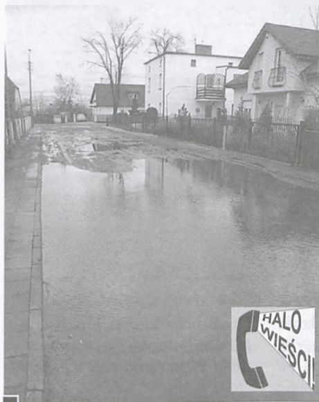
Zdaniem mieszkańców, stan ul. Tuwima można poprawić tworząc wzdłuż krawężnika rowek odprowadzający wodę na ul. Dąbrowskiego (do burzówki) oraz ulicą Hibnera do Potoku Junikowskiego fot. Piotr P. Ruszkowski
