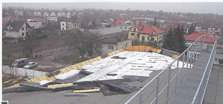
Z dołu nowoczesny, stylizowany na fałę dach hali wygląda imponująco. W rzeczywistości okazało się, że kształt dachu uzyskano przy pomocy płyty wiórowej pokrytej papą, a z widocznej z dołu, zewnętrznej strony – blachą. Bezpośrednio pod papą – dla ocieplenia – ułożono styropian fot. Leszek Michalik
