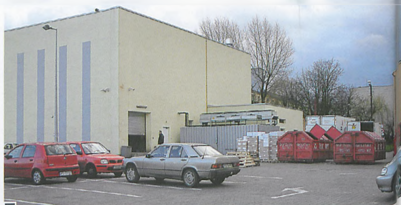
Zniszczona przez wiatr metalowa konstrukcja pomiędzy budynkiem Pajo Centrum a marketem budowlanym uszkodziła 4 samochody stojące na parkingu. Informację tę podała też lokalna telewizja fot. Hanna Siatka
