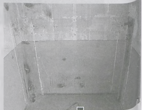
Klatka schodowa. Przed kilkoma laty wycięto tu cały system grzewczy. Do dziś pozostały dziury w stropach i ścianach. Przydałoby się przynajmniej pozatykanie dziur i malowanie fot. Piotr P. Ruszkowski
