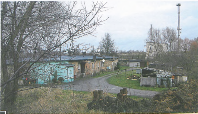
Widok na położony w dole budynek komunalny – od strony ul. Sikorskiego. Z prawej – szopki na opał i ubikacje, w miejscu których będzie parking dla nowego bloku Lubonianki fot. Hanna Siatka
