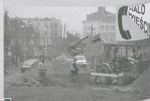
Mieszkańcy rejonu ul. Konarzewskiego skarżą się na wolne tempo prac przy budowie kanalizacji, bałagan organizacyjny, zniszczenia i brak bezpieczeństwa fot. Paweł Jankowiak
