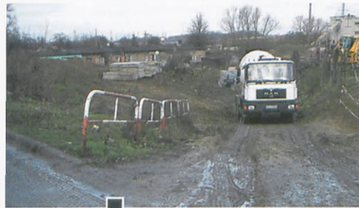
Eksploracja jedynej drogi do baraku przez sprzęt budowlany sprawia, że dojazd do komunalni stał się niemożliwy fot. Hanna Siatka
