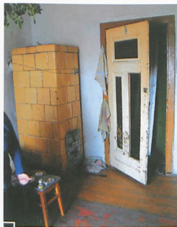
W tym lokalu, od 4 lat bez prądu, zamieszkuje starsza kobieta. Wilgoć, zmurzałe okna, chłód. Drzwi wejściowe są w gorszym stanie niż widoczne na zdjęciu wewnętrzne. Listonosz wrzuca pocztę do korytarza przez kilkucentymetrową szparę fot. Hanna Siatka
