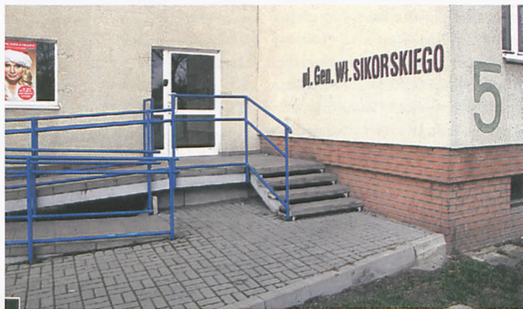
Wejście na zaplecze budynku z udogodnieniami dla niepełnosprawnych, gdzie znajdują się automaty do obrotu gotówką fot. Piotr P. Ruskowski
