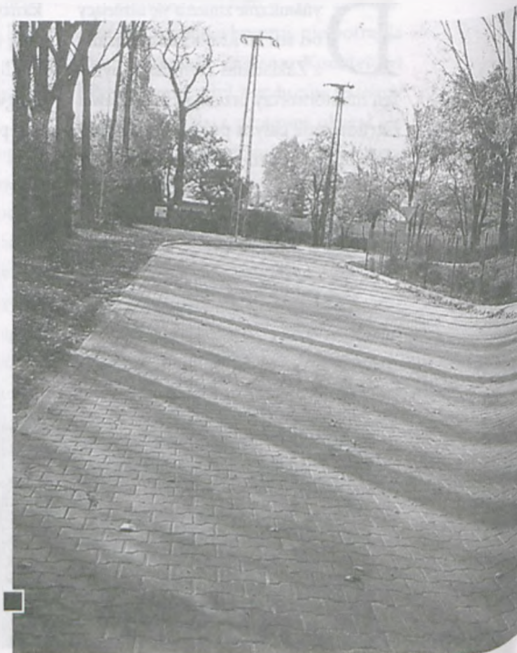
Brukowana droga do grobli przy Zakładach Chemicznych fot. Katarzyna Frąckowiak
