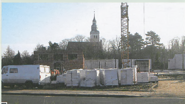
Widok powstającej inwestycji od strony autostrady fot. Hanna Siatka
