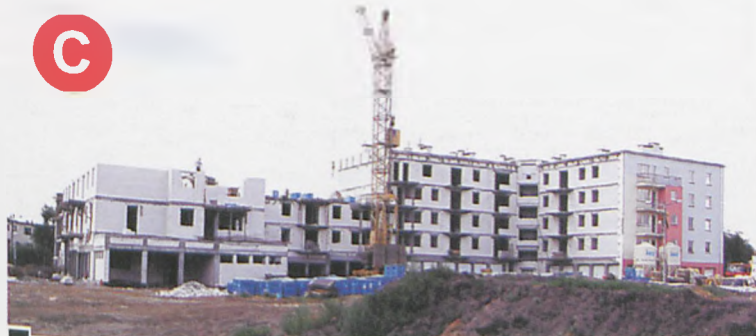
Bloki firmy BUDOM-LOMEX przy narożniku ulic Broniewskiego i Konarzewskiego (patrz mapka i zdjęcie – C) fot. Piotr Paweł Ruszkowski
