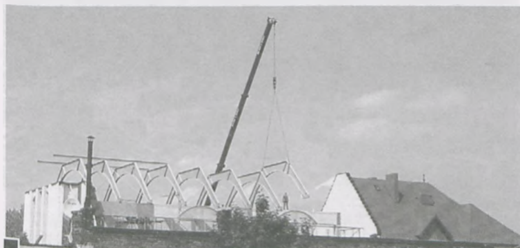
Montaż stalowej konstrukcji dachu (zdjęcia wykonane 13 czerwca) fot. Paweł Jankowiak
