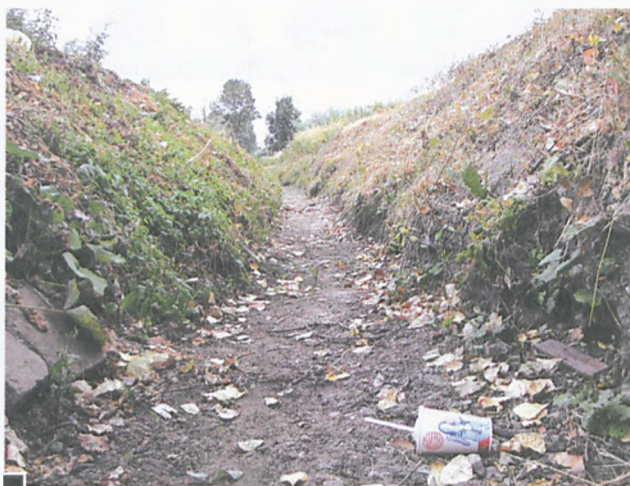
Najstarsi mieszkańcy nie pamiętają wyschniętego koryta potoku Żabinka przepływającego przez Luboń. Tak wyglądał on na początku sierpnia wzdłuż ul. Nad Żabinką – do ul. Sienkiewicza. fot. Piotr Paweł Ruszkowski
