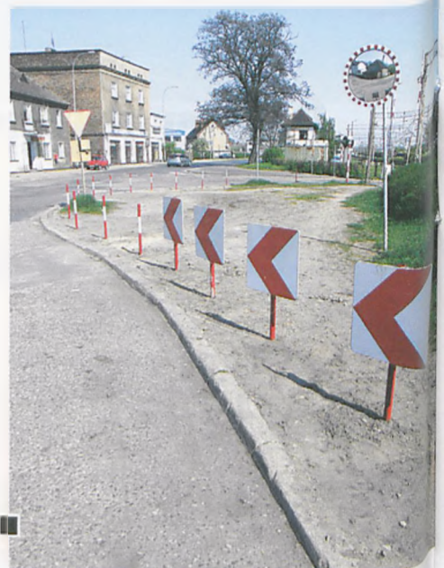
Niebezpieczne skrzywienie ul. Dworcowej oznakowane fot. Paweł Jankowiak
