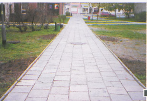
Miejsca po usuniętych ławkach fot. Katarzyna Frąckowiak
