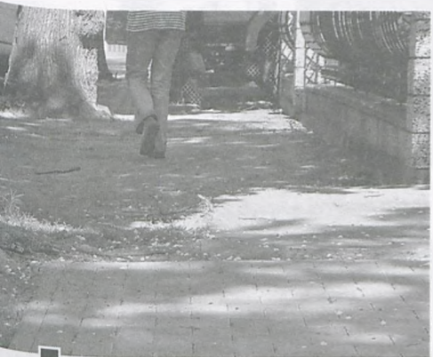
Na pierwszym planie – przerwana na długości jednej posesji inwestycja. Przechodźnię kieruje się wprost na na wysunięte ogrodzenie – bezsensowną przeszkodę fot. Hanna Siatka
