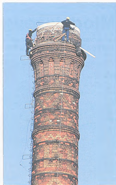
We wrześniu br. przeprowadzono prace zabezpieczające zwieńczenie zabytkowego kominu
