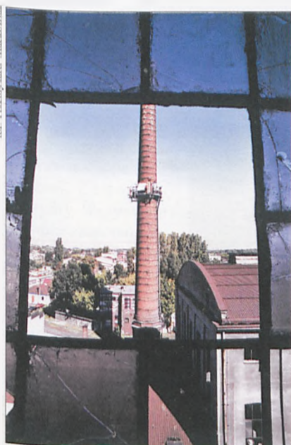
Zabytkowy komin jest ostatnim zachowanym na terenie połączonych w 1949 r. Fabryki Przetworów Ziemniaczanych oraz Fabryki Drożdży
