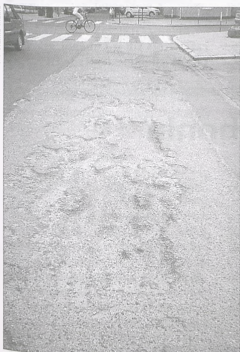
Nawierzchnia wokół placu przed regeneracją
