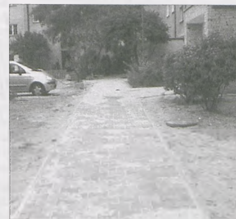
Odnowiona część chodnika przy ul. Sikorskiego
