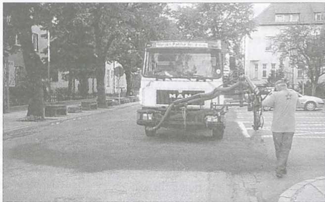
Natryskowe wypełnianie ubytków nawierzchni jezdni
