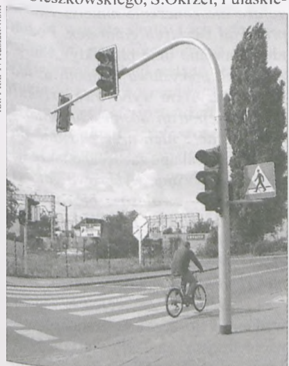
Nowa sygnalizacja świetlna – przy Zakładach Ziemiaczanych
