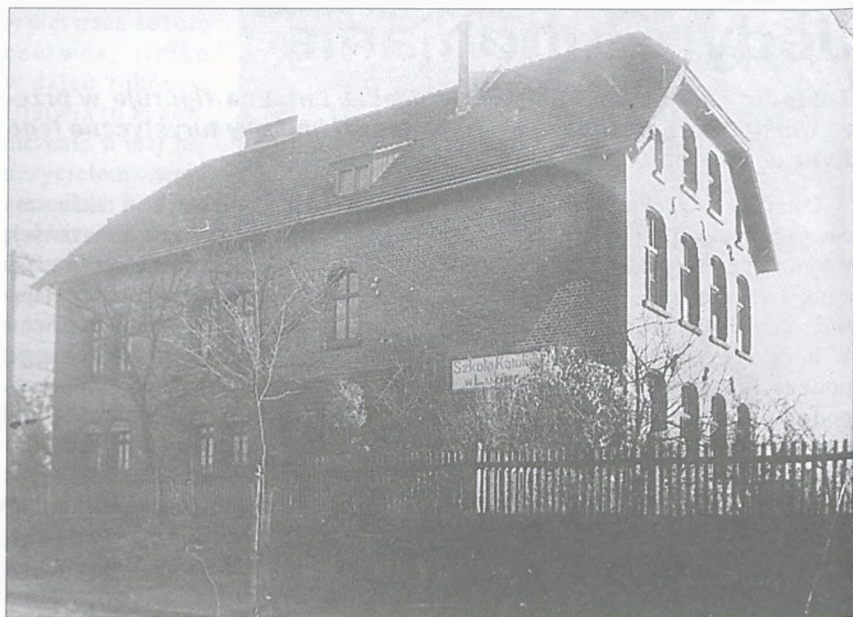
Pierwsza szkoła lubońska wybudowana w 1904 r. (zdjęcie z lat 20. XX w.) W latach 90. po oddaniu do użytku nowego gmachu, miała ulec rozbiórce. Budynek uratowało Towarzystwo Gospodarcze Miasta Lubonia (obecny właściciel). Dziś gmach starej szkoły jest zabytkiem użytkowanym przez Prywatne Liceum Ogólnokształcące im. płk. Kiedacza
