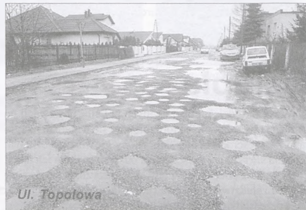
Podczas, gdy inne nieutwardzone ulice w Luboniu są trudne do przebycia z uwagi na grząskie błoto lub ogromne kałuże (np. ul. Podgórna), ul. Topolowa stanowi przykład nieprzejezdnej drogi ze względu na małe wyboiste dziury.
