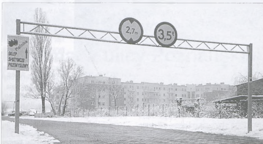
„Brama” do nowego osiedla. Za nią rozpoczyna się droga prowadząca do kilkudziesięciu mieszkań, wybudowana nie przez miasto a przez dewelopera
