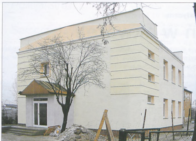
Stara szkoła przy ul. Sobieskiego w nowym kształcie architektonicznym – domem komunalnym dla 6 rodzin
