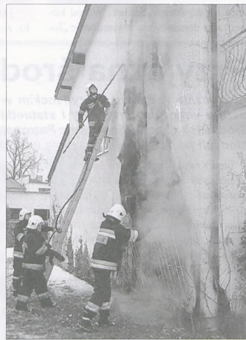
Podczas akcji gaszenia ocieplenia budynku na ul. Lipowej (28.01.2005 r.)
