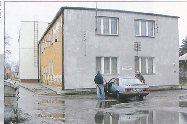
Niemodernizowana część budynku od strony podwórza dla 9 rodzin
