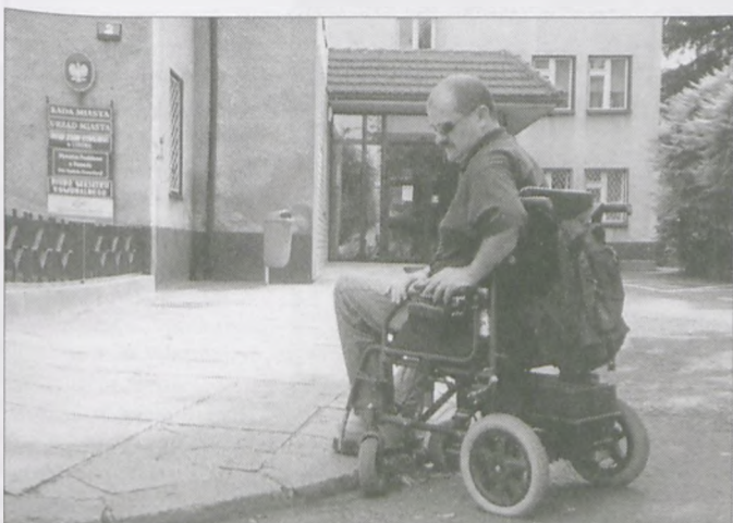
W tle budynek urzędu miasta z funkcjonalnym podjazdem – niestety nikt nie pomyślał o obniżeniu krawężników.
