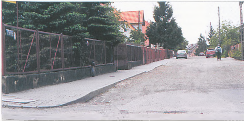
Podczas obfitego deszczu woda z ulicy, posiadającej naturalny spad w kierunku ul. Traugutta, zalewa posesje położone najniżej
