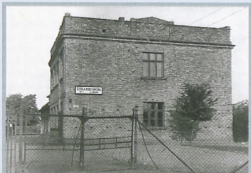
Stara szkoła SP4. Budynek ten przy ul. Sobieskiego od kilku lat czeka na zaadoptowanie na mieszkania komunalne
