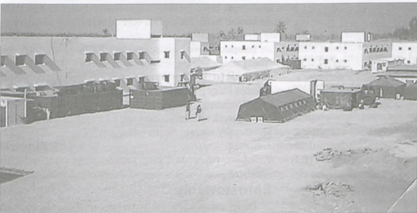
Przy pomocy Arabów w ciągu 2 miesięcy udało się doprowadzić bazę do stanu widocznego na zdjęciu.
