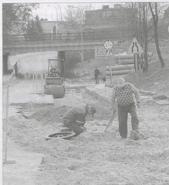
Zakładanie kolektora sanitarnego na ul. Powstańców Wlkp.
