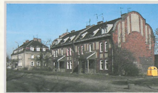
Wprowadzenie wielkiego przemysłu do Lubonia na początku XX w. przyczyniło się bezpośrednio do zasiedlenia tych ziem i stopniowej zmiany ich rolniczego charakteru. Na zdjęciu dom z 1904 r. o secesyjnych szczytach, jeden z pierwszych budynków mieszkalnych Zakładów Ziemniaczanych.
