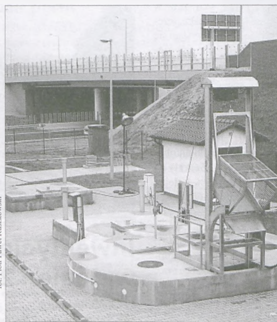
Nowa megaprzepompownia poczeka jeszcze rok
