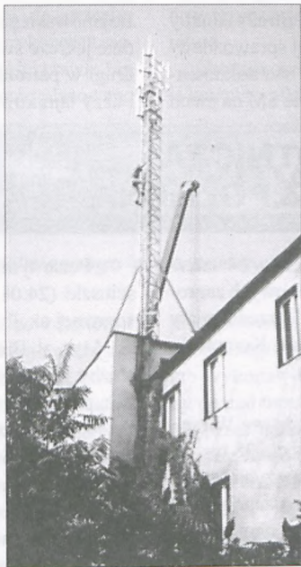
Demontaż anteny
