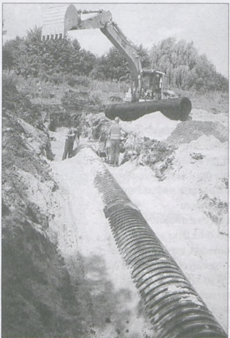
W poprzek nowej drogi układane jest odwodnienie
