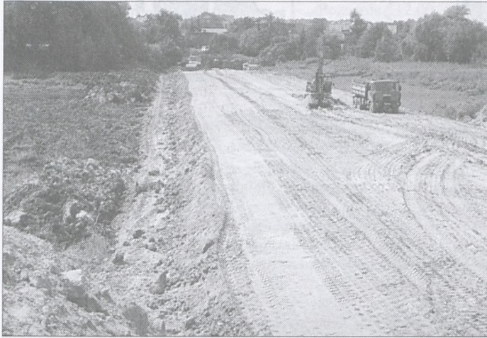
Budowa drogi przez bagna w kierunku ul. Puszkina. Z lewej strony widoczna ziemia bagnista wybrana spod nasypu
