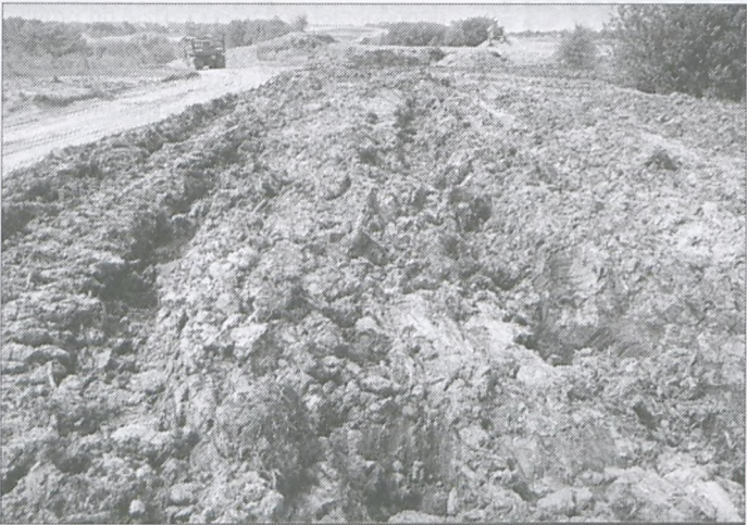
Ciężka gliniasta ziemia organiczna pochodząca z wykopu (miała być torfem) składowana w pobliżu budowanej drogi
