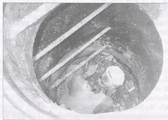
Usuwanie gruzu z dna zatkaniej studzienki
