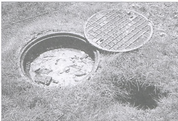
Studzienka kanalizacyjna przed odetkaniem. Obok widoczny odstojnik, powstały po przelaniu się zawartości studzienki.
