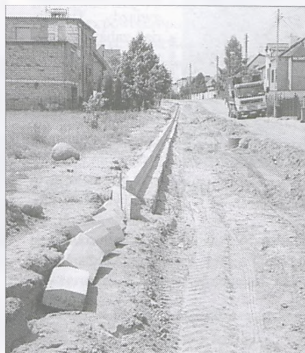
Budowa nawierzchni ul. Buczka
