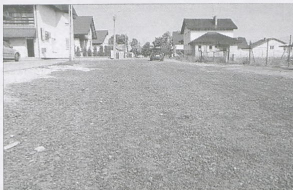
Na skutek telefonicznej interwencji jednej z mieszkanki, w pierwszej połowie maja ul. Leśmiana (na odcinku należącym do miasta) wysypano popreżem (sfrezowaną z innych ulic nawierzchnią asfaltową)
