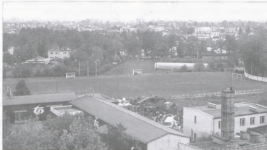
Luboń z wieży kościoła św. Barbary
