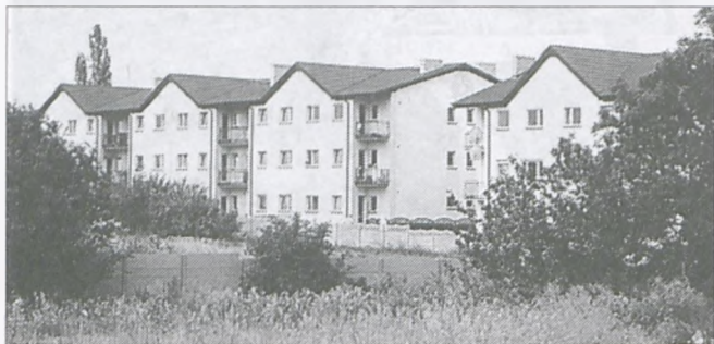
Trzypiętrowe bloki w zwartej zabudowie traktowane jako budownictwo jednorodzinne
