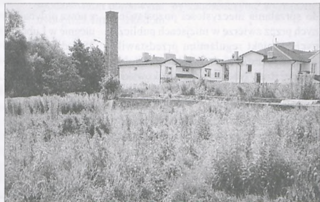
Teren, na którym stanąć mają domy MAXBUD-u. Z tyłu – osiedle KOS-DOMu, z lewej – miejsce, przez które płynie Żabinka
