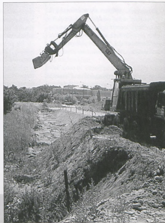
Roboty przy zwięzaniu drogi
