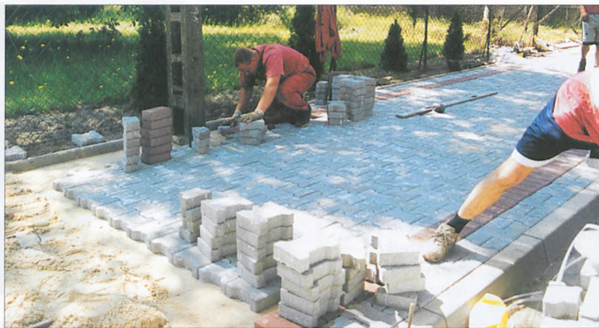
Układanie chodnika na ul. Poniatowskiego. Niektórym zabytkowym lipom przycięto korzenie.
