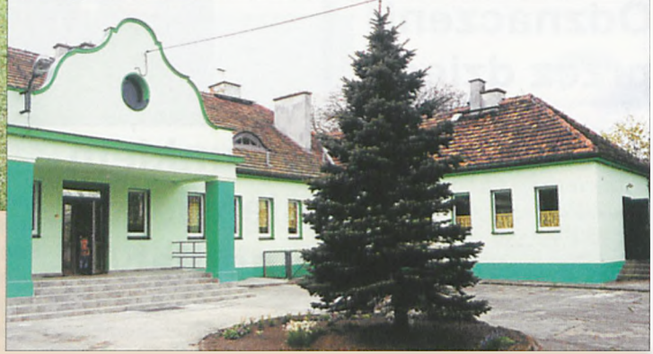
Przedszkole ma wyremontowane kafelkami schody i nową elewację
