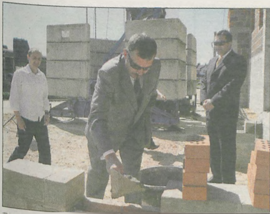
Za kielnię chwycił nie tylko Adam Pawlicki. Murarskiej roboty nie odmówił sobie również starosta Stanisław Martuzalski, budowlaniec z wykształcenia
