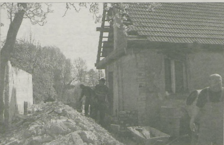
W MINIONĄ ŚRODĘ rozpoczęło się stawianie nowej ściany szczytowej
