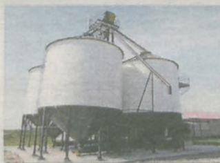
Linie technologiczne magazynów zbożowych
