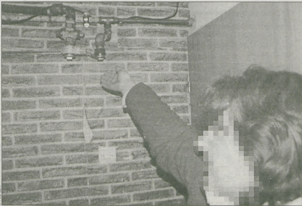
Zawinił kierownik, a odbiorcom odcięto dopływ gazu
