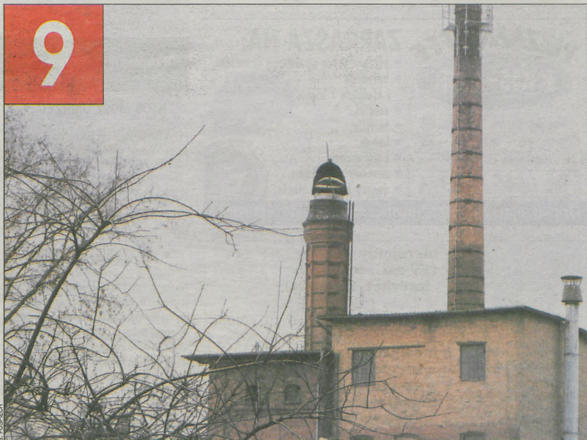
Już wkrótce stare zabudowania browaru przejdą gruntowną modernizację
