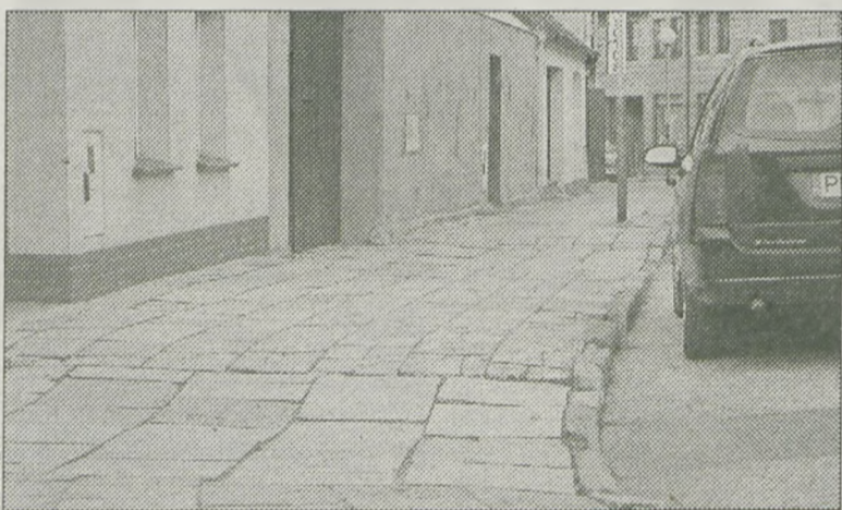
Nieestetyczne płyty zastąpi kostka brukowa
