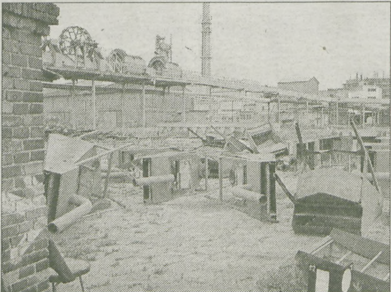
Czy znajdą się chętni na zniszczony obiekt?
