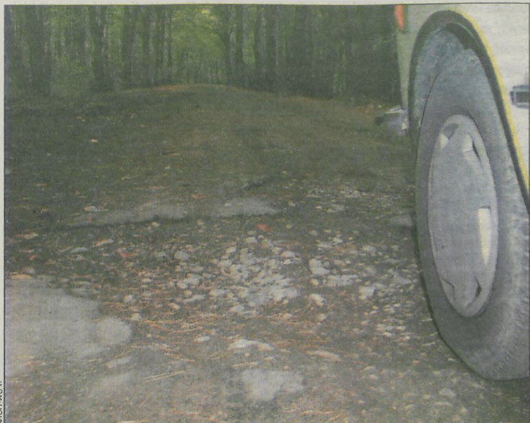
Nie wiadomo, kiedy rozpocznie się remont jezdni i budowa ścieżki rowerowej
