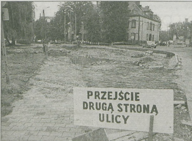
W tym miejscu powstaną nowe miejsca parkingowe
