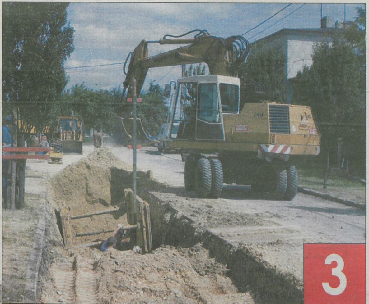
Zdjęcie zrobione w czasie zeszłorocznych robót kanalizacyjnych na osiedlu Parcelki
