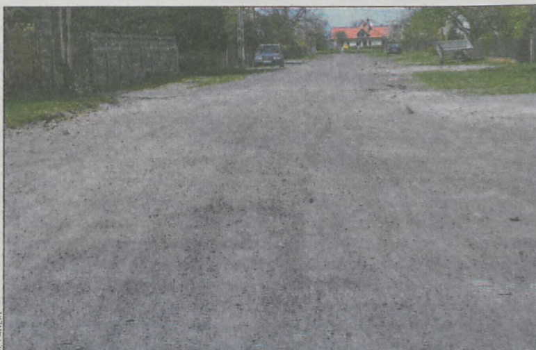
Tym razem nawierzchnię wyrównano bardziej solidnie
